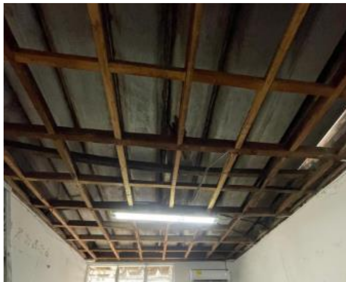
Ilustración 17: Estructura cubierta ginecología
