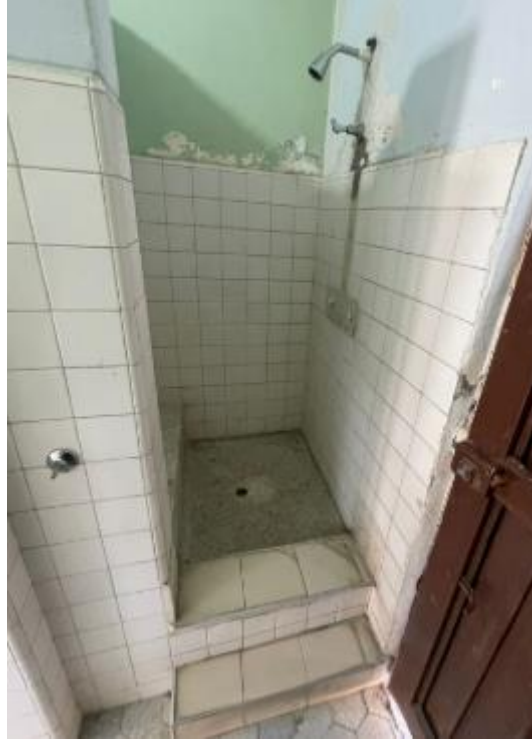
Ilustración 5: Enchape paredes baño hospitalización pediátrica
